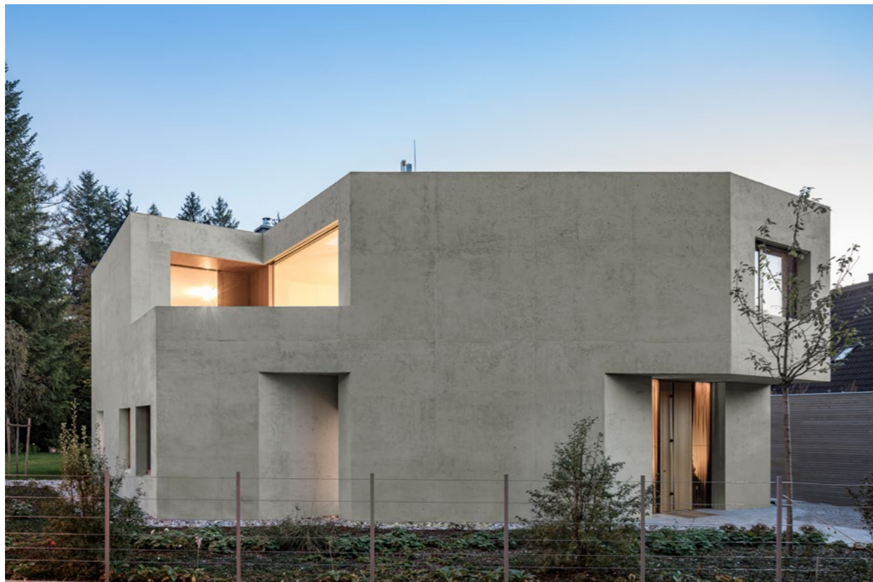
Exterior view Außenansicht Vue extérieure
