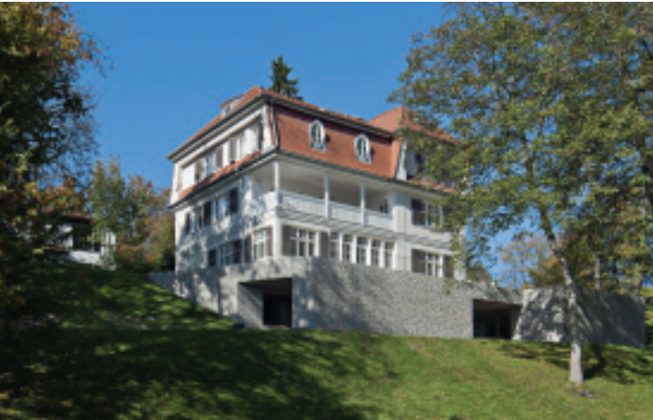
Die historische Villa wurde sorgsam restauriert und talseitig um einen Wellnessbereich mit gespitzter Sichtbetonfassade ergänzt.
