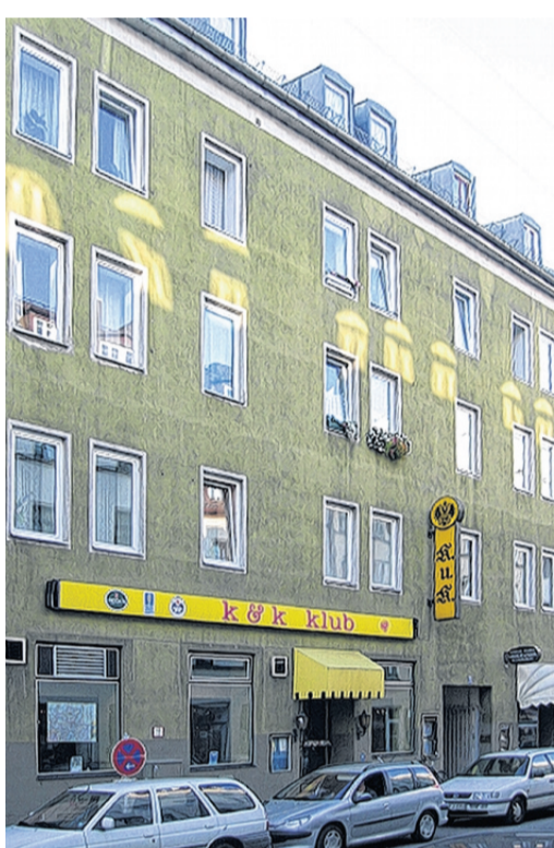
Nicht wiederzuerkennen: Die schreiend hässliche Reichenbachstraße 22, nachdem in den 60er Jahren der Stuck abgeschlagen worden ist.
