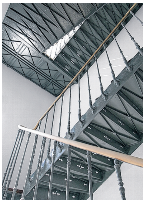
Zu den Wohnungen geht es jetzt wieder über ein grünes Eisen-Treppenhaus.
